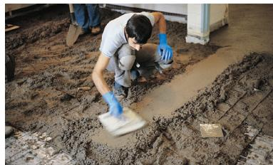
◆ comme pour une chape traditionnelle, réaliser des repères avec le mortier ainsi obtenu, puis mettre ce mortier en place et régler
