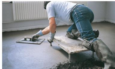
◆ réaliser le talochage dans les 15 minutes qui suivent le réglage
